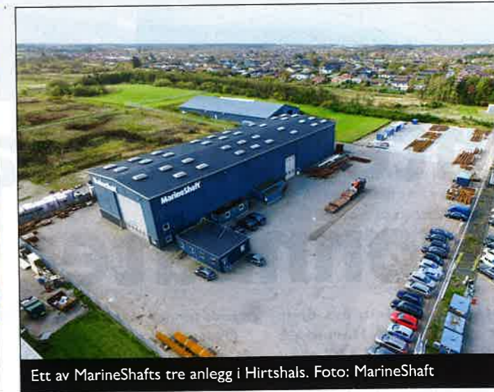
MarineShaft har utviklet sin egen metode for å rette opp akslinger osv. uten bruk av varmepåvirkning, bare ved hjelp av mekanisk press. Foto: MarineShaft
